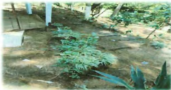
Foto 3: AMPLIACIÓN DE LA FOSA SÉPTICA PARA SANITARIOS
