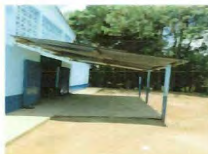
Foto 4: SUSTITUCIÓN DE LA ESTRUCTURA DEL TECHO, COSTANERAS Y PARALES (Corredor de la escuela)
