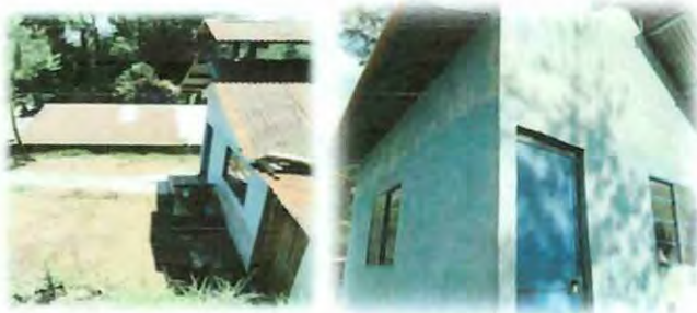
Foto 1: AMPLIACIÓN DE LA COCINA, PISO CERÁMICO, LÁMINAS Y ESTRUCTURA DE TECHO
