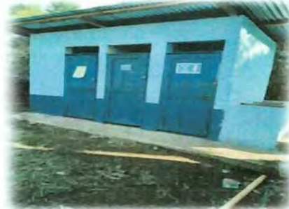
Foto 2: AMPLIACIÓN DE 2 SANITARIOS Y UN MIGITORIO (culata de la escuela)
